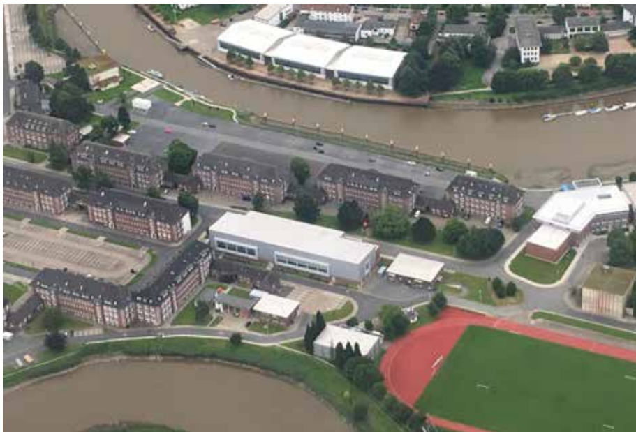
Die „Überleben auf See (ÜaS)-Halle (weißes Gebäude Bildmitte) in der Marineoperationsschule (MOS) in Bremerhaven (Fotos: MarkDo)
